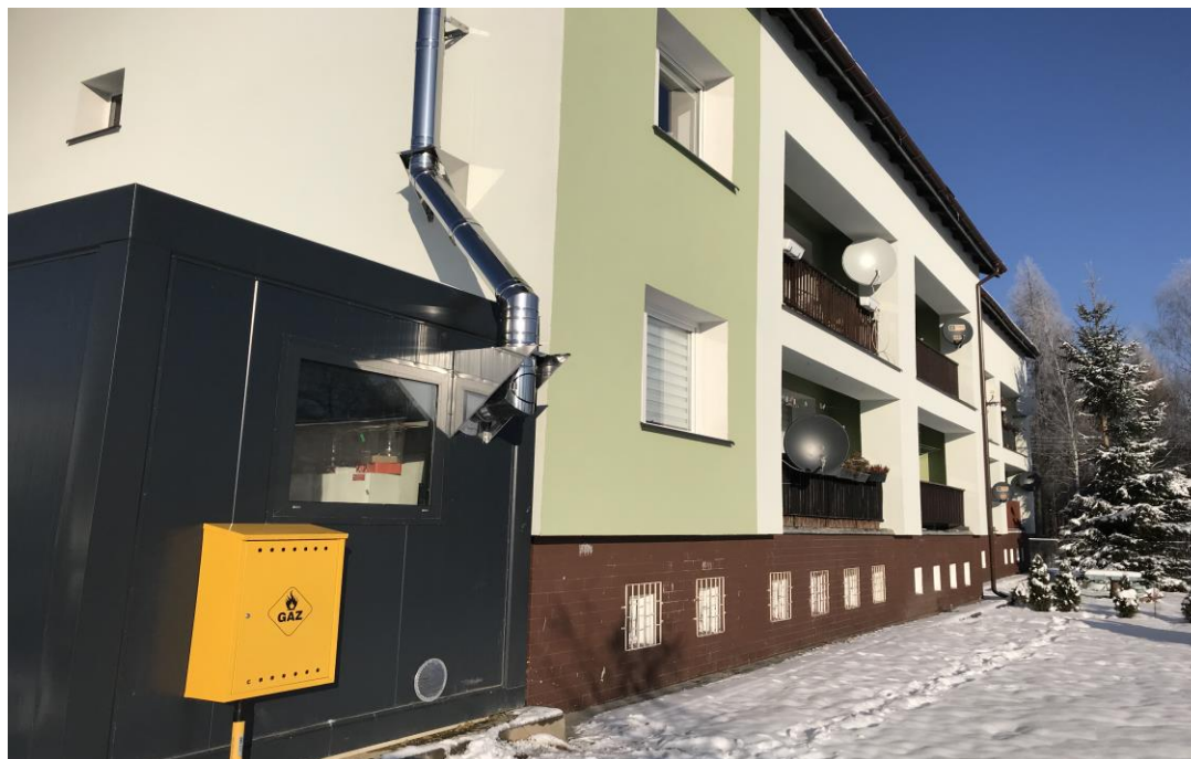
Budynek mieszkalny nr 4 – elewacja południowa oraz Kotłownia.
