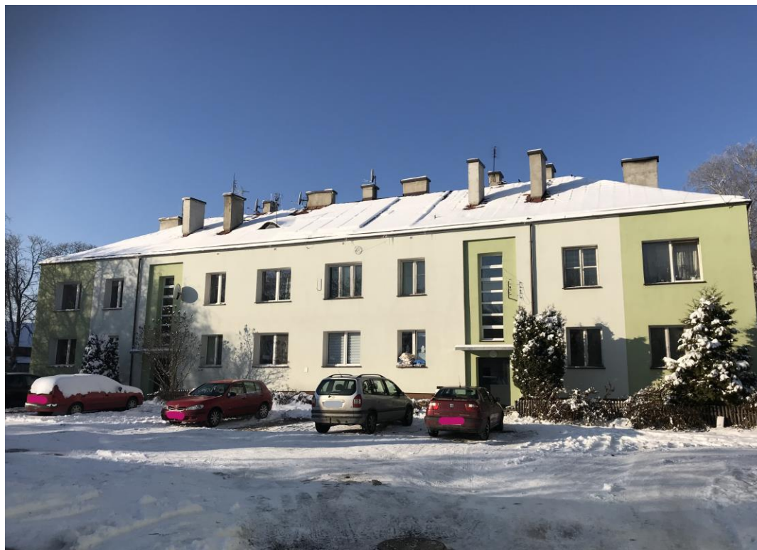
Budynek mieszkalny nr 1 – widok na elewację południową
