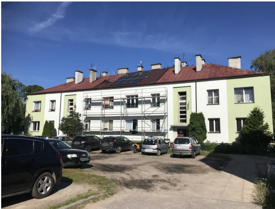
Budynek mieszkalny nr 1 – elewacja południowa
