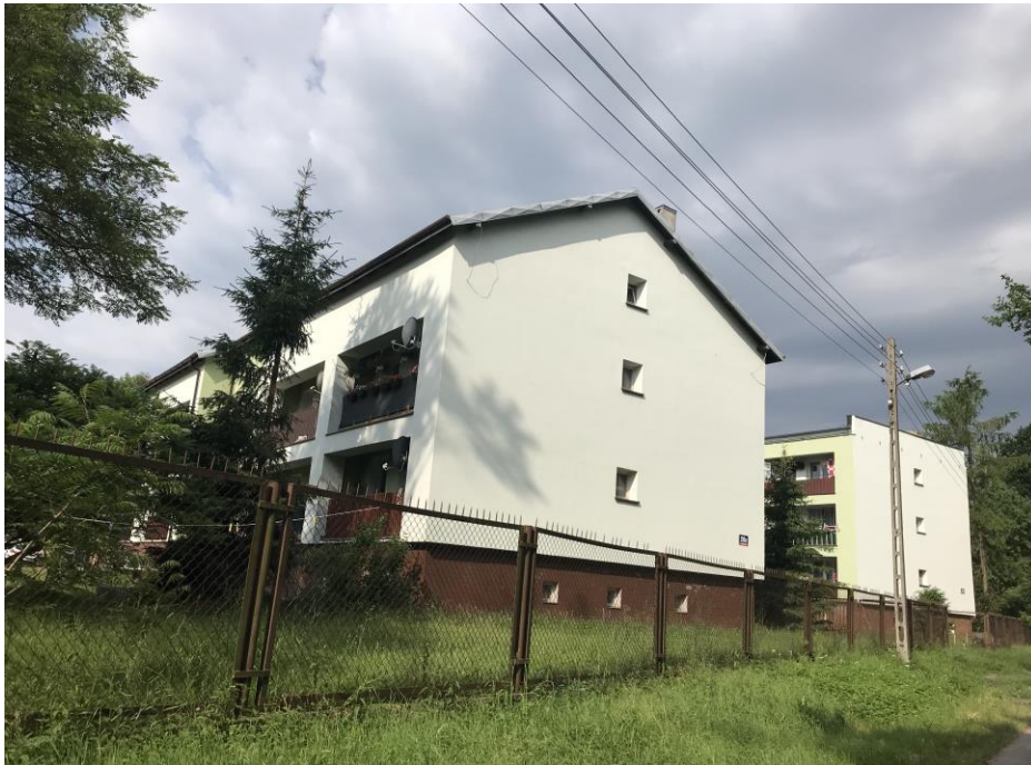
Budynek mieszkalny nr 4 i nr 3 - elewacja zachodnia
