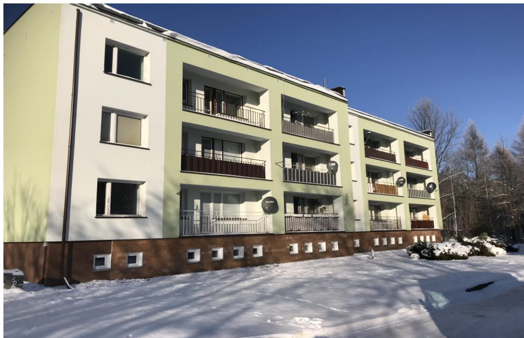
Budynek mieszkalny nr 3 elewacja południowa
