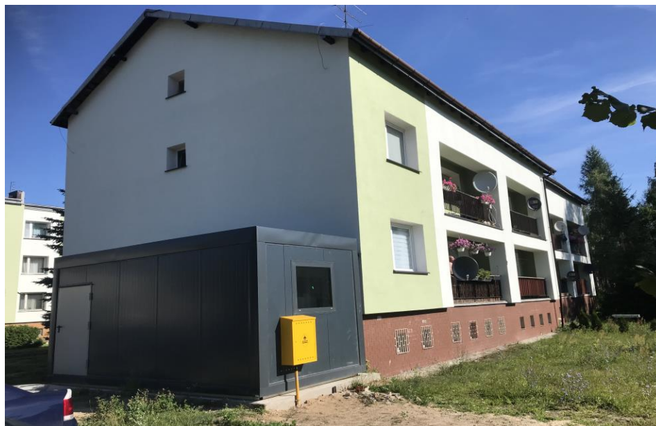
Budynek mieszkalny nr 4 -elewacja południowa i wschodnia oraz Kotłownia
