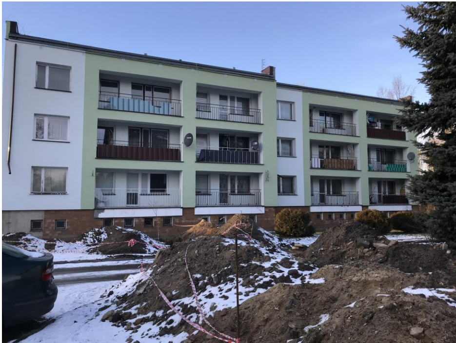
Budynek mieszkalny nr 3 elewacja południowa
