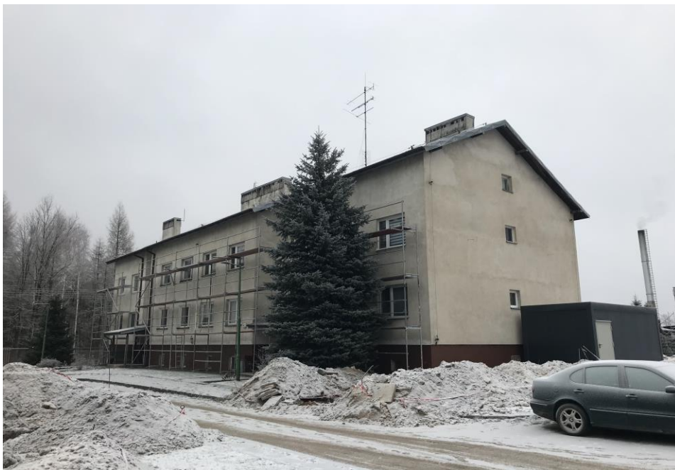
Budynek mieszkalny nr 4 - elewacja północna oraz budynek Kontenerowej kotłowni na gaz.
